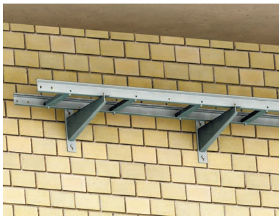
Монтаж опор до стіни на консолях монолітних
