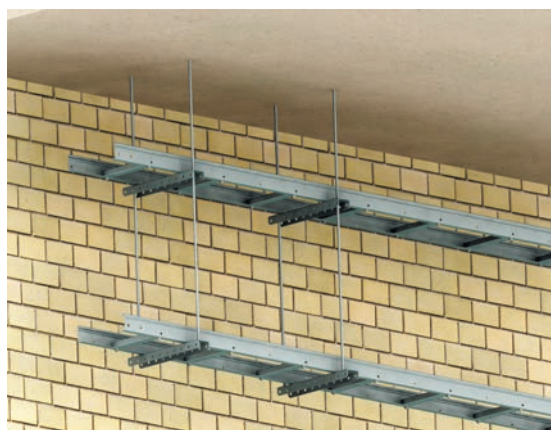
Монтаж опор до стелі на шпильках в 2 рівня
