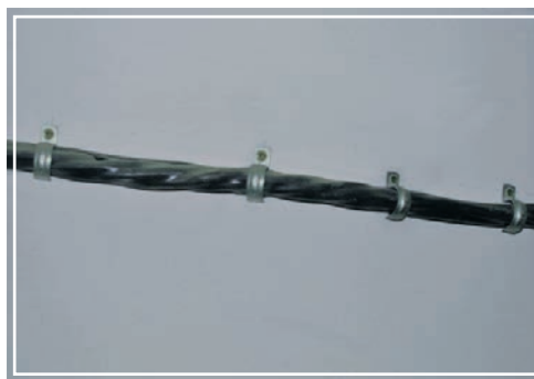
Приклад кріплення кабелю за допомогою скоби монтажної металевої
