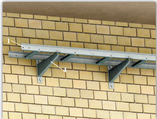
Монтаж опор до стіни на консолях монолітних
