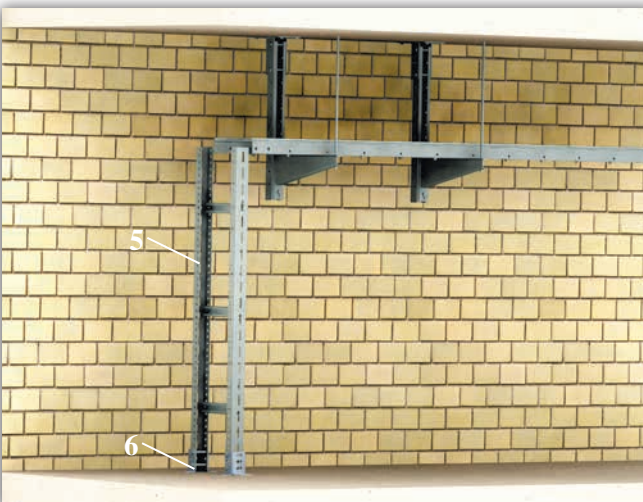
Перехід з горизонтального на вертикальний монтаж на станинах до підлоги
