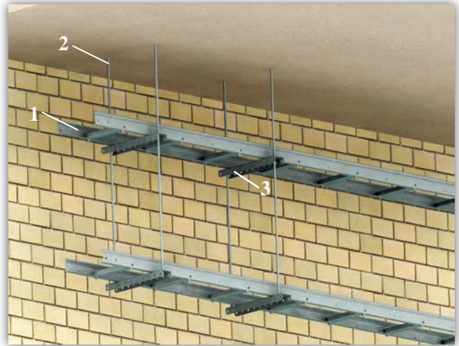
Монтаж опор до стелі на шпильках в 2 рівня
