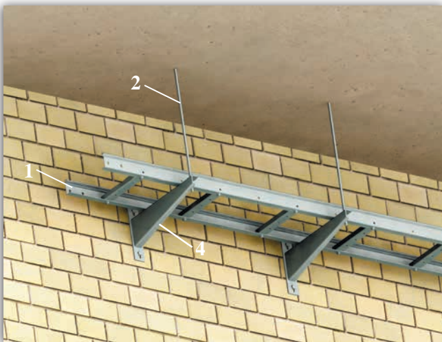
Монтаж опор до стіни і стелі на консолях монолітних за допомогою шпильок
