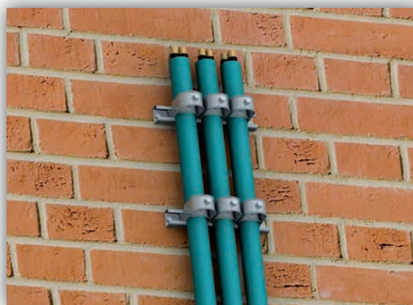
До стіни за допомогою затискача LCU/V
